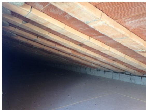
Figura 4.1 - Particolare della porzione di involucro del sottotetto non riscaldato
