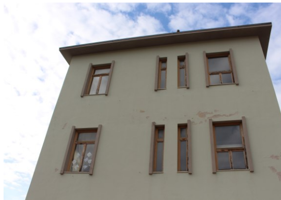
Figura 1.1 - Vista della facciata esposta a Nord-Est
