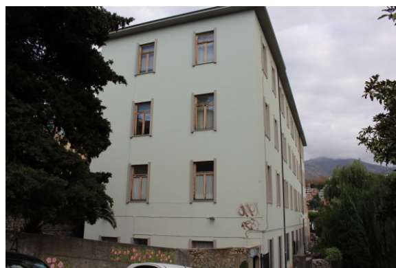
Figura 4.2 - Particolare della facciata est
