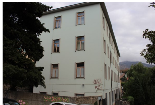
Figura 8.1 - Particolare della facciata esistente
